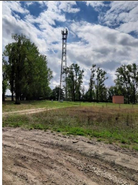
Abbildung 18: Funkmast und Gebäude des Sportplatzes
